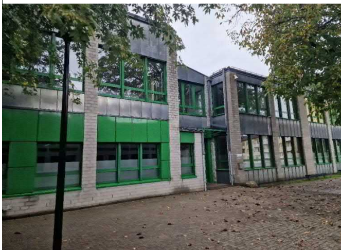
Abbildung 9 Ungedämmte Außenwände
