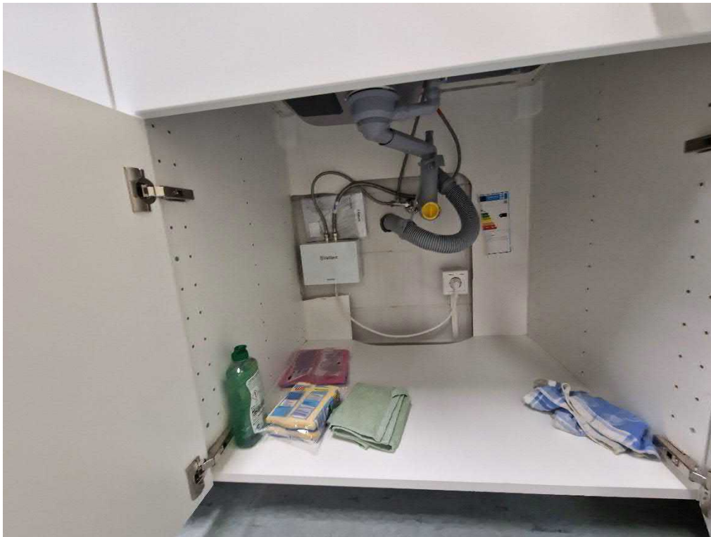
Abbildung 12 Untertisch-Kleinspeicher
